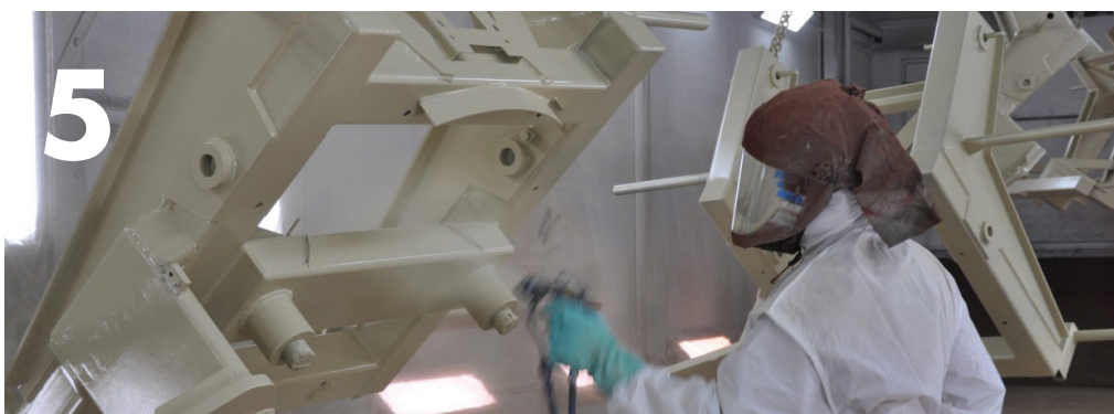
Après le traitement anti-corrosion, suivent l'application des 2 couches primaires PUR puis la couche adhésive et la prévention anti-corrosion.
